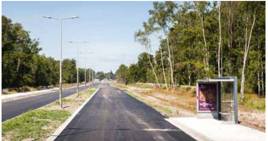
VOIE NOUVELLE MARCEL DASSAULT.
