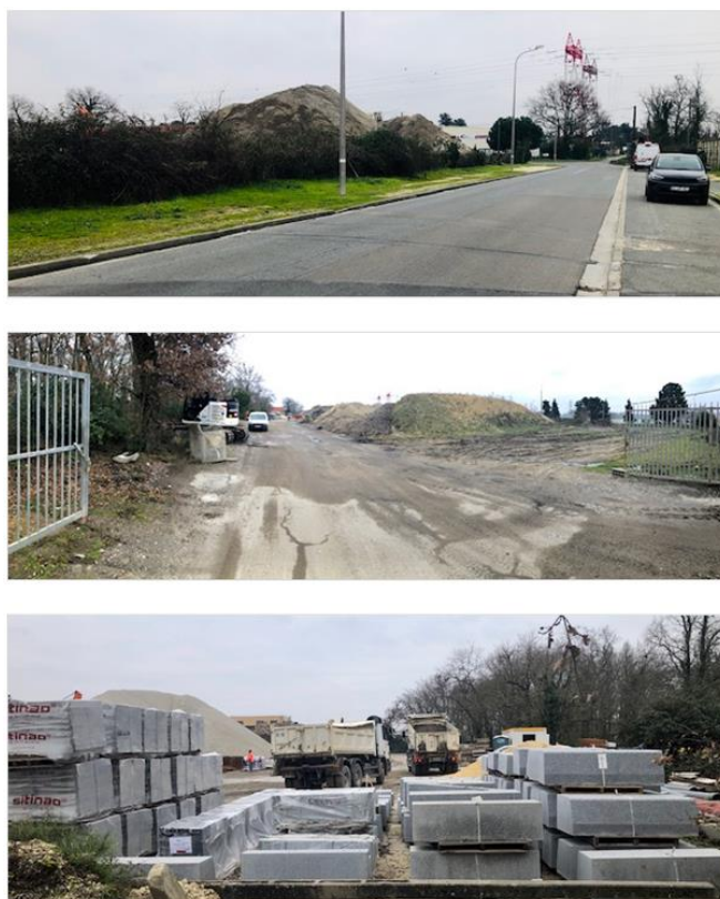
Figure 25 : Entreprise de matériaux comprenant plusieurs terrils de gravats ou graviers au droit du terrain de propriété RTE (RTE, 2023)
