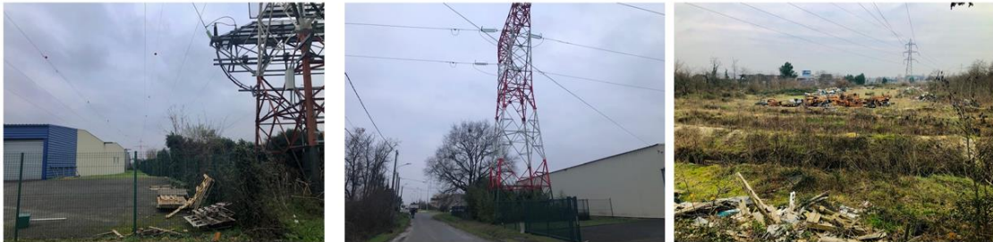
Figure 24 : Photographies des supports depuis l'impasse M. Lévy (Mérignac) (RTE, 2023)
