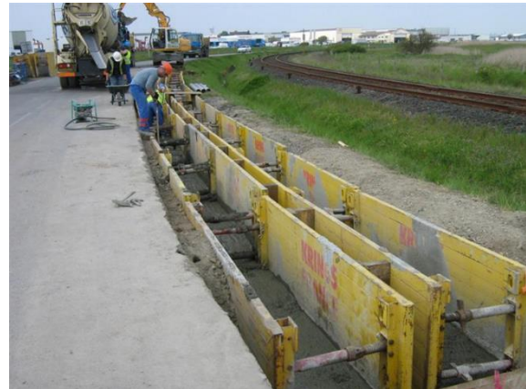
Figure 16 : Photo de chantier de pose de liaison double en milieu routier (RTE)
