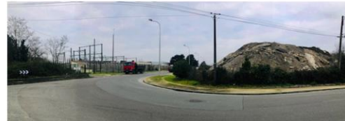
Au sud : à gauche le poste 63kV de Mérignac, à droite le terrain RTE
