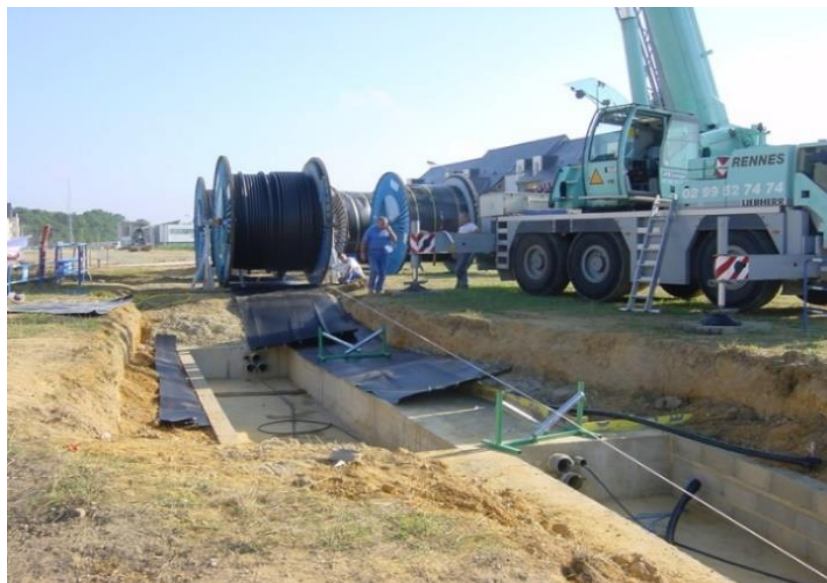
Figure 19 : Exemple de déroulage de câble (RTE)
